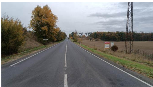
Stav silnice po opravě
