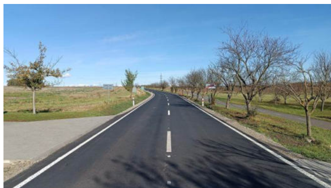
Stav silnice po opravě
