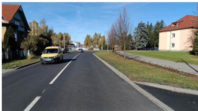
Stav po opravě
