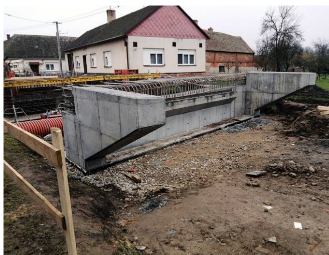
Stav během rekonstrukce (most)
