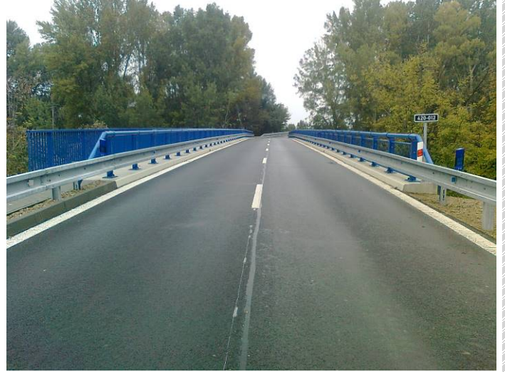
Stav po rekonstrukci – most
