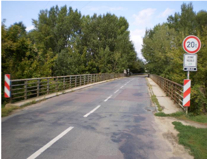
Stav před rekonstrukcí – most
