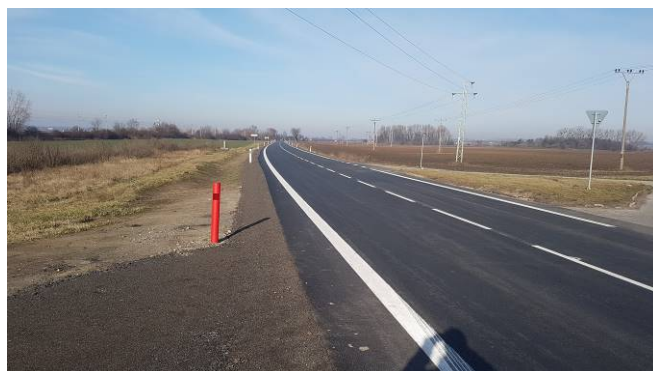
Stav po rekonstrukci
