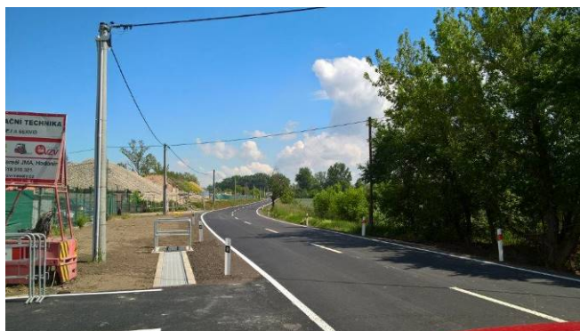
Stav po rekonstrukci
