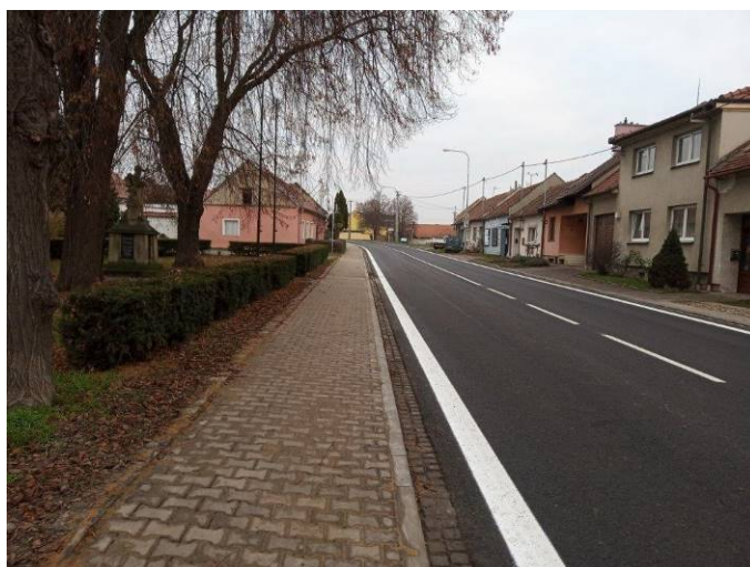
Stav silnice po rekonstrukci
