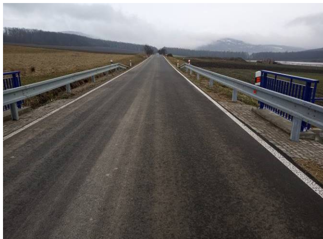
Stav po rekonstrukci
