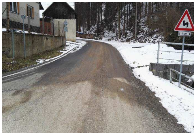
Stav po rekonstrukci
