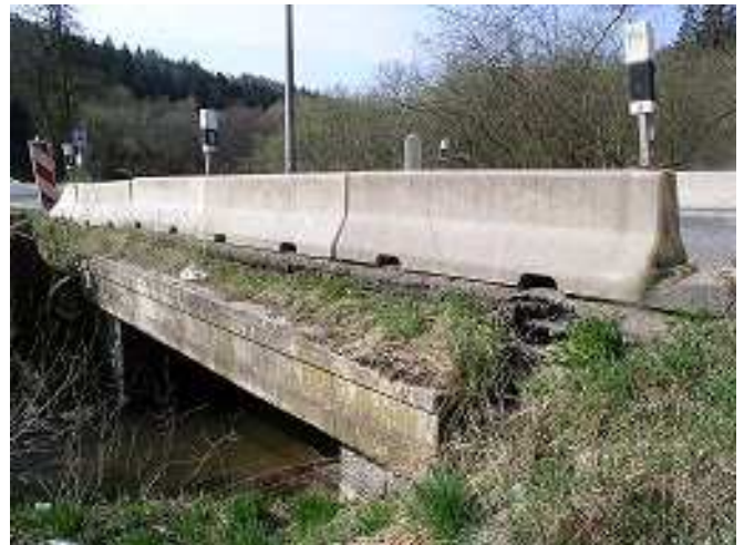
Stav před rekonstrukcí
