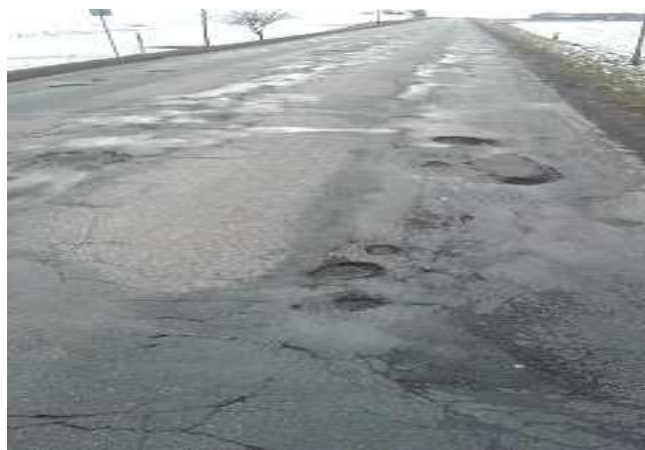
Stav před rekonstrukcí
