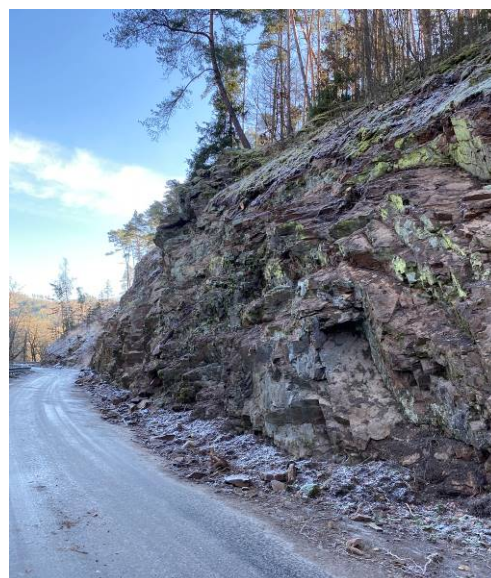
Stav po sanaci
