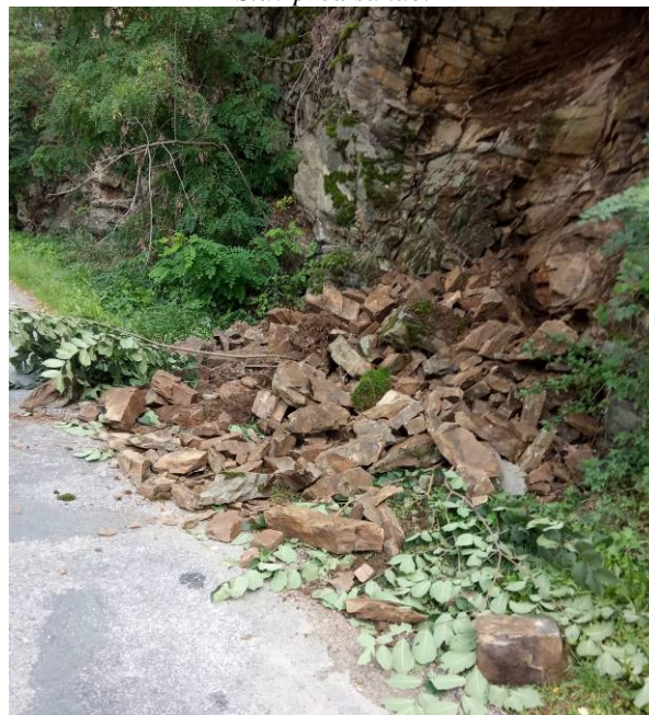
Stav před sanací
