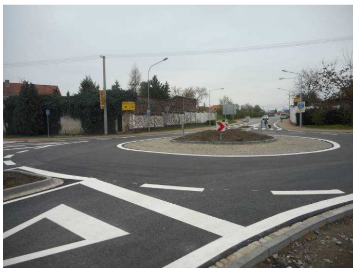
Stav po rekonstrukci
