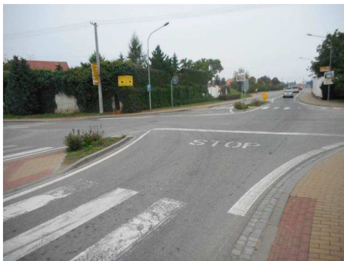
Stav před rekonstrukcí
